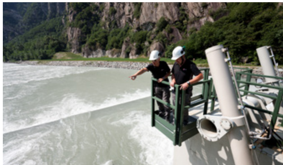
Centrale di Bard
