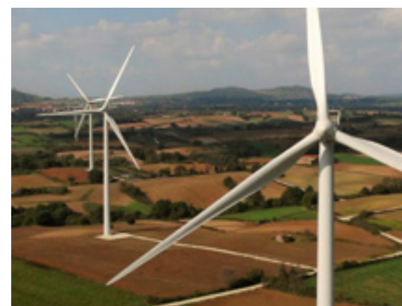
Parco eolico di Piansano
