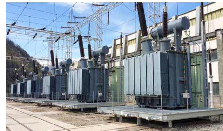
Centrale di Valpelline: monitoraggio DGA online dei 6 trasformatori monofase
