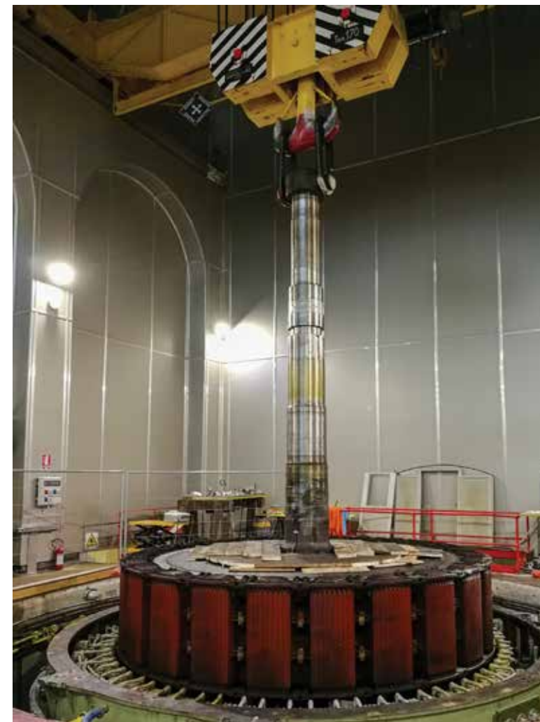
Estrazione rotore della centrale di Hône 1
