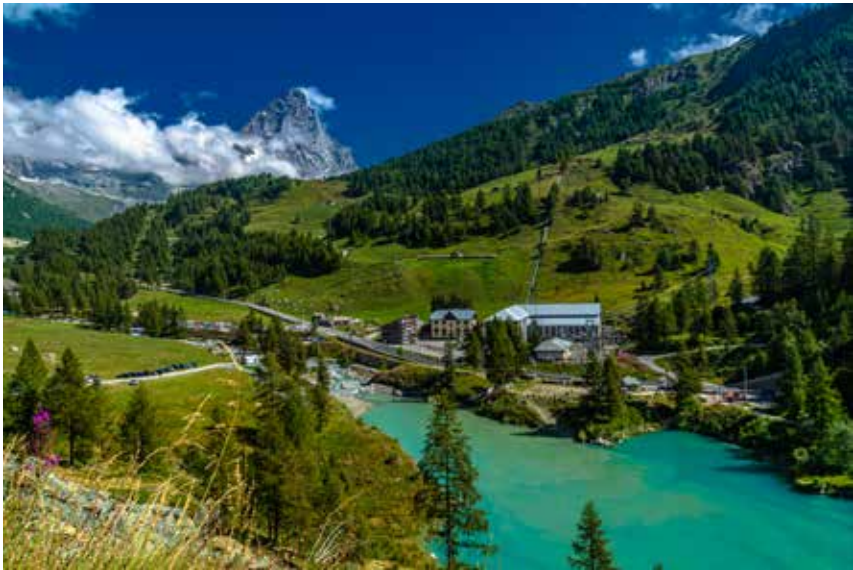
Centrale di Perrères
