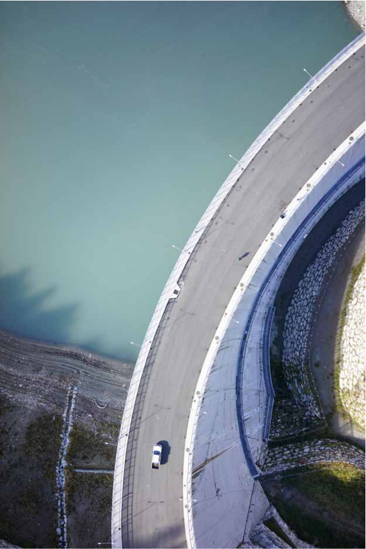
Vista aerea della Diga di Beauregard
