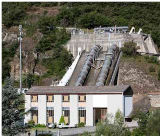
Centrale di Montjovet
