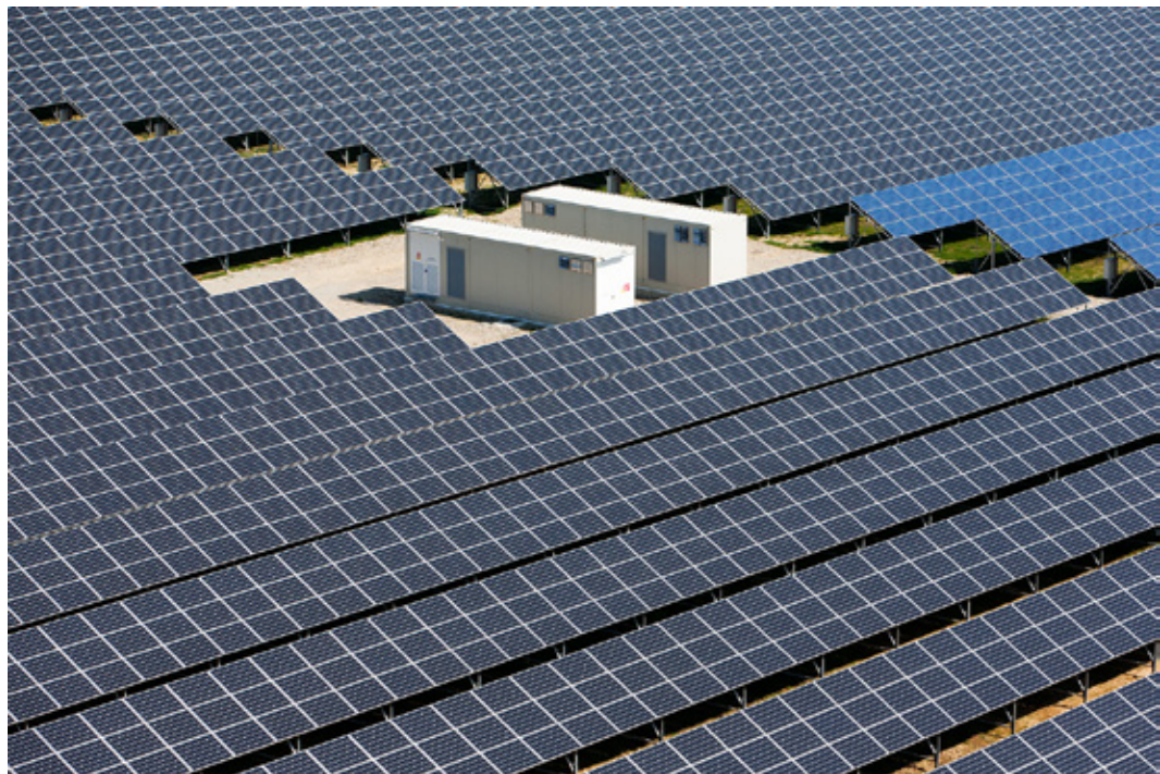
Impianto fotovoltaico di Valenza Fornace (AL)
