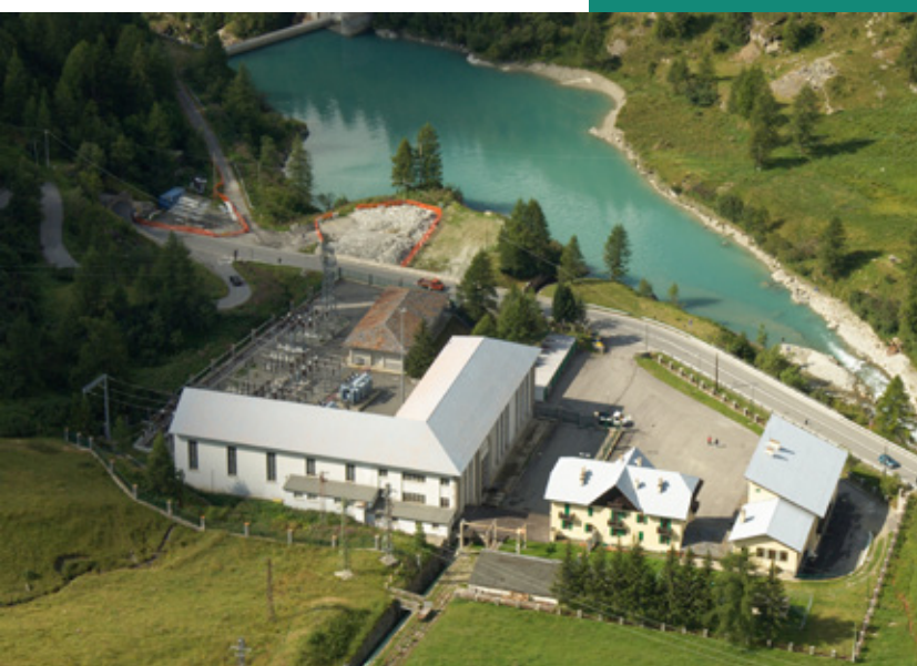
Centrale idroelettrica di Perrères, Valtournenche (AO)
