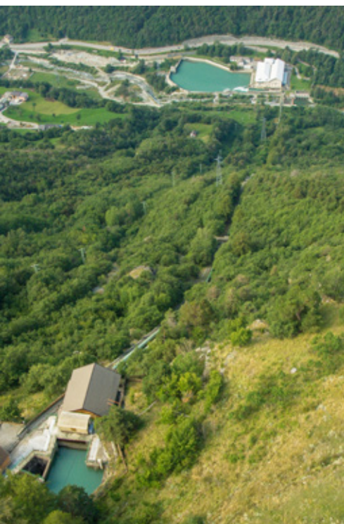
Centrale idroelettrica di Covalou (AO)
