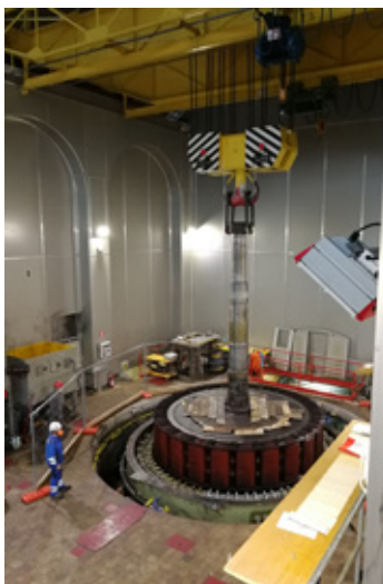
Sostituzione dell'albero turbina nella centrale idroelettrica di Hône (AO)
