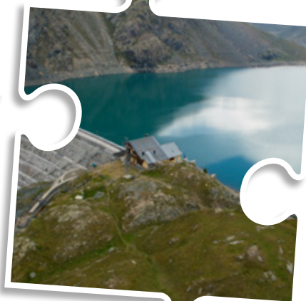
Diga del Gabiet
