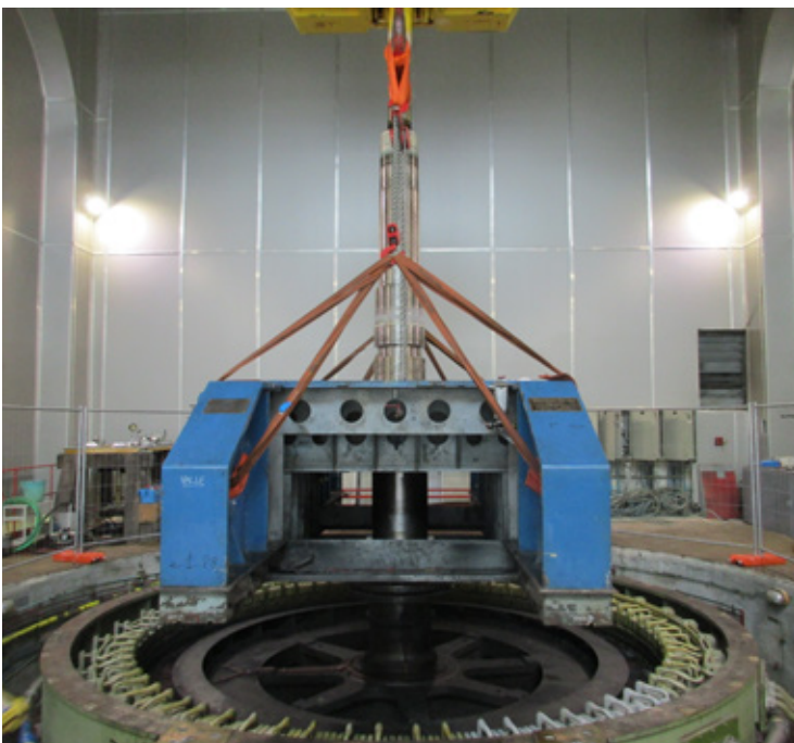
Intervento ad una pala della ruota Kaplan nella centrale idroelettrica di Hône (AO)
