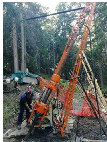
Sondaggio in zona vasca di carico.
